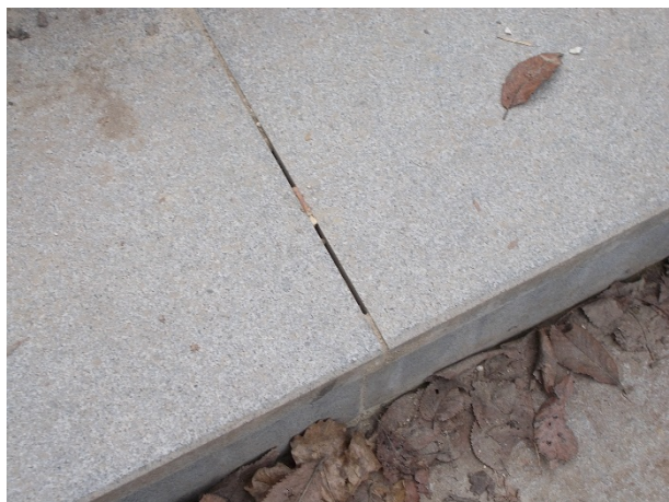
Fedkő ragasztása nem megfelelő
