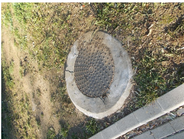
Aknafedlap beton gallérja nem megfelelő
