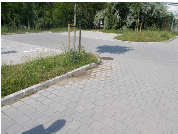
Aknafedlap beton gallérja nem megfelelő
