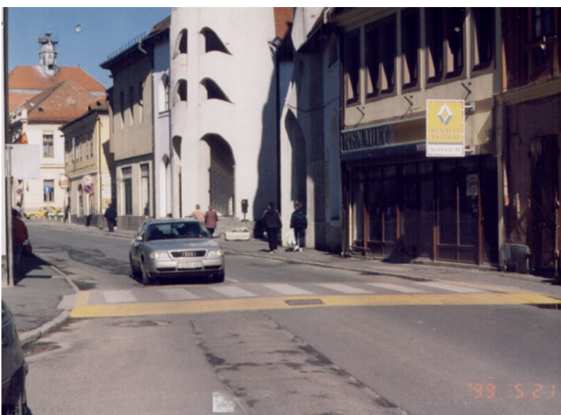
Szigetvár, útburkolati küszöb
