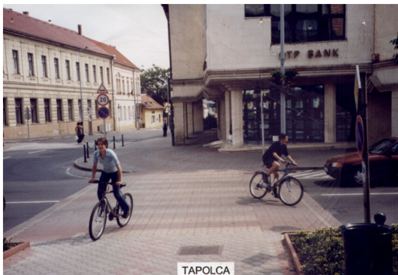
Tapolca, útburkolati küszöb kijelölt gyalogátkelőhellyel
