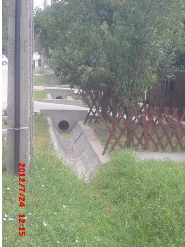
Biai Gáspár utca másik oldala – nyílt, betonozott elvezető árok, növényzetmentes
