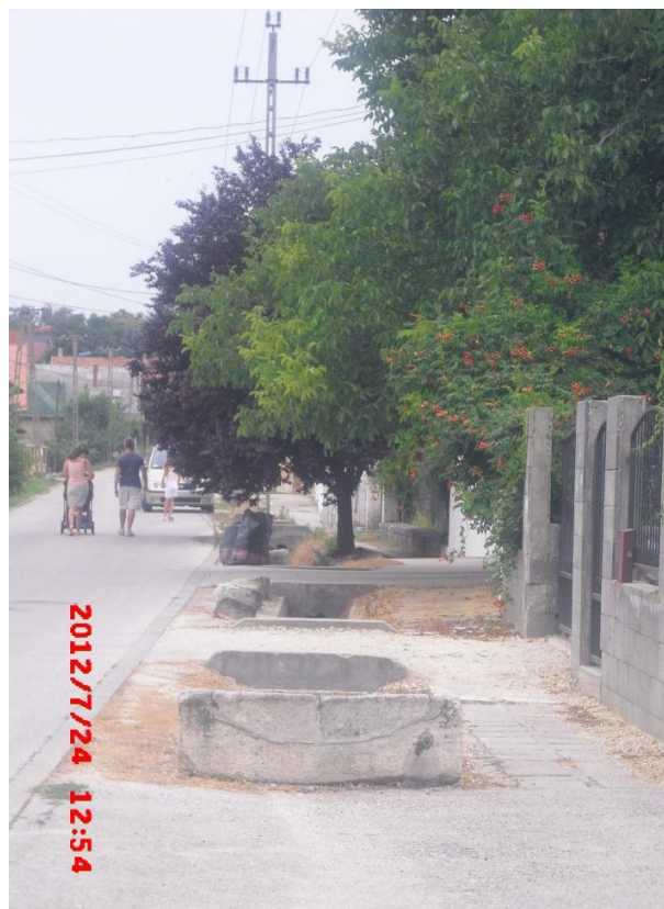
Nyitott csapadécszatna, növényzet mentes, betonozott – Rákóczi Ferenc utca
