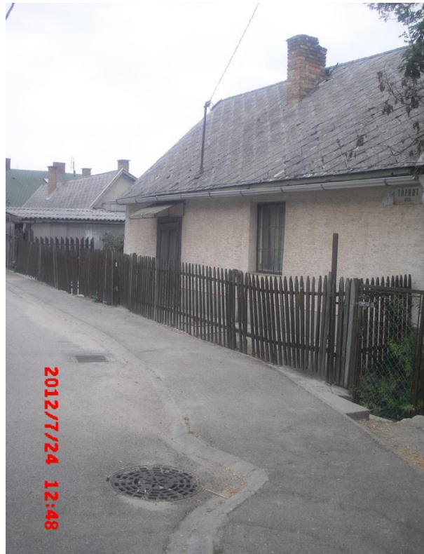
Zárt csapadékvízvezetés - Tópart utca
