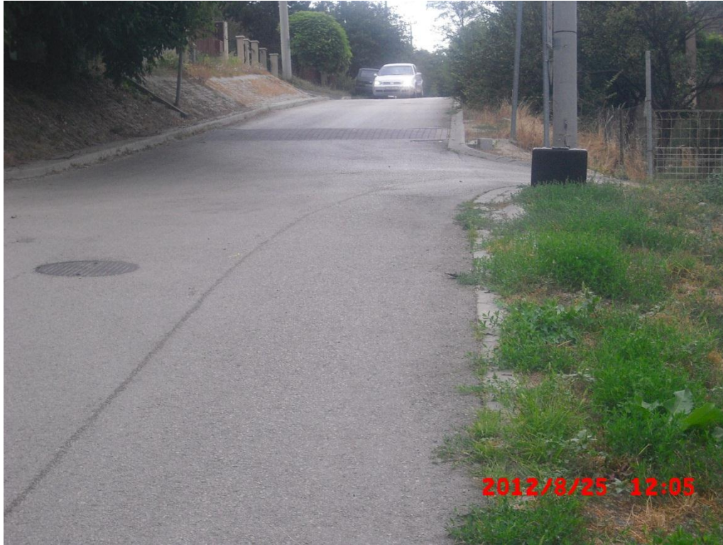
nyitott csapadékelvezető árok – Jókai utca közepe
