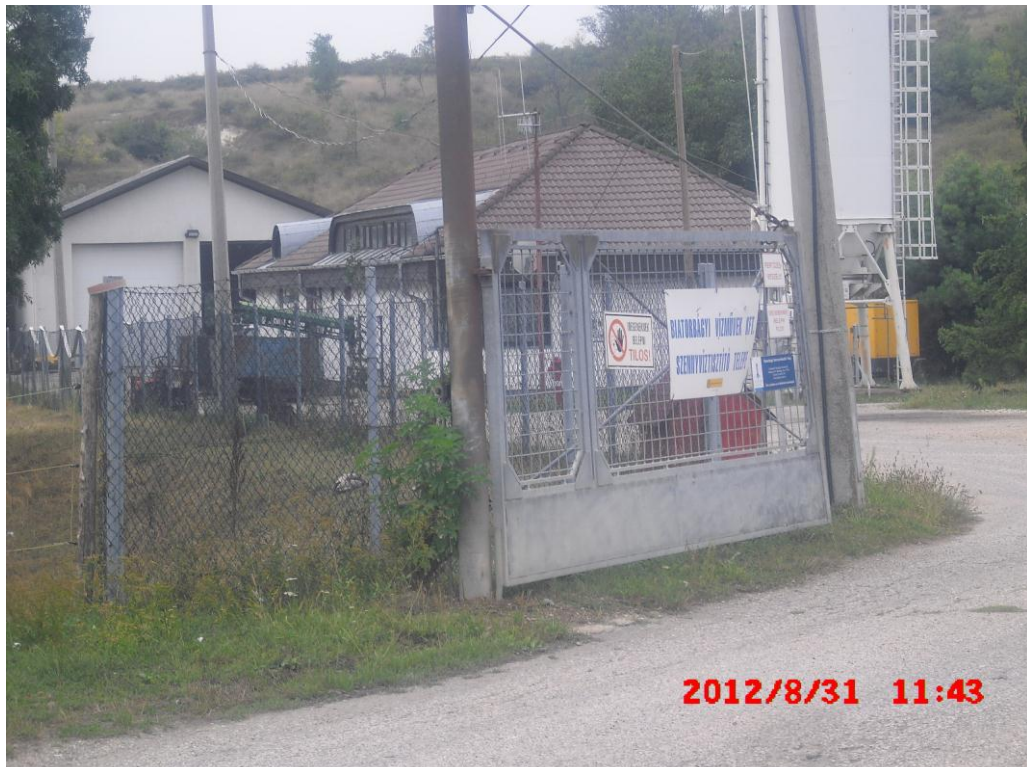
szennyvíztisztító telep – bejárat, balra a kiszolgáló épületek
