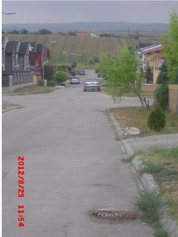
zárt szelvényű csapadékelvezetés – András utca
