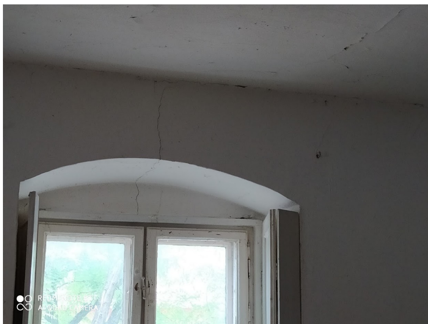
Az átrepedt boltozat, látható a repedezett mennyezet
