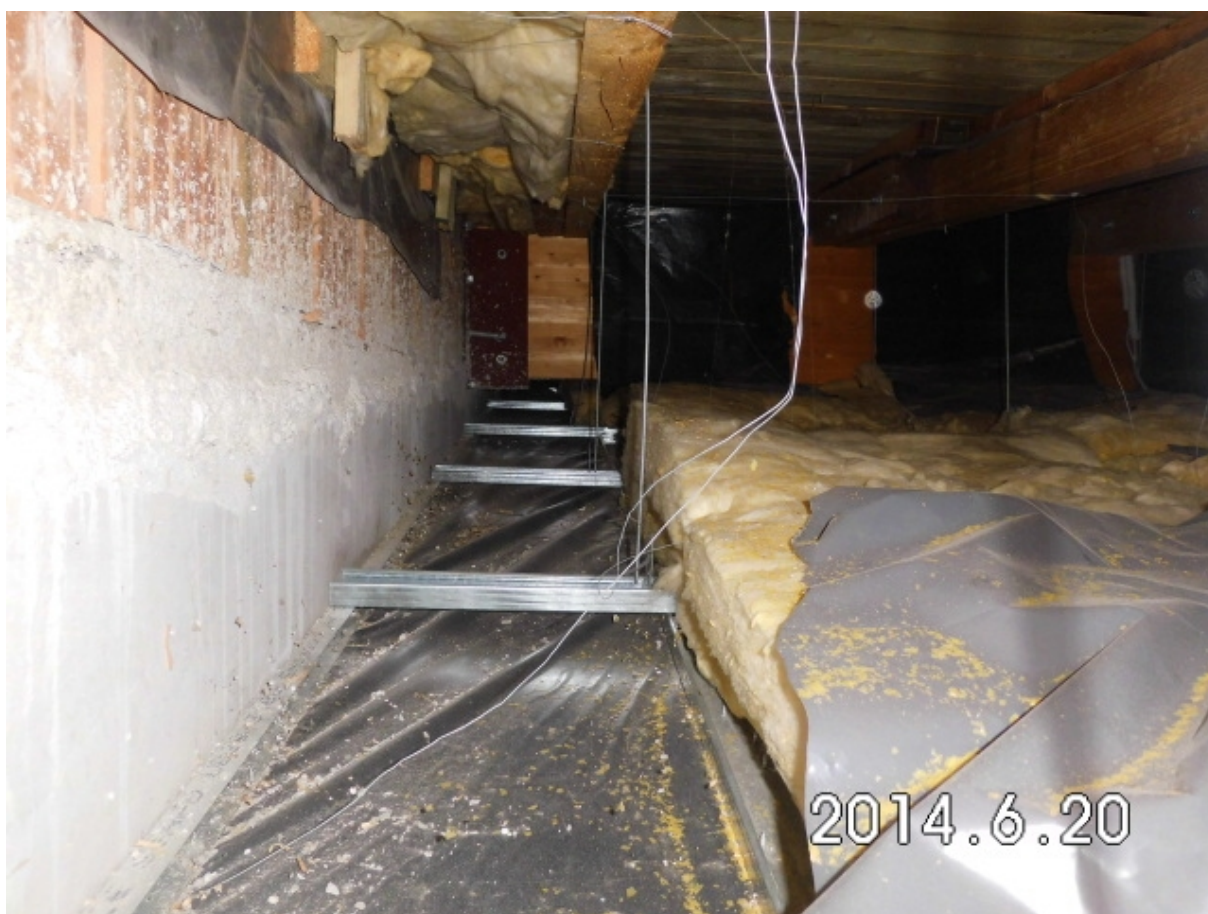
Padlástéri hőszigetelés hiánya
