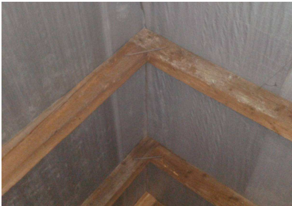
Taréjszelemen és taréjfogópár nélküli gerinckialakítás
