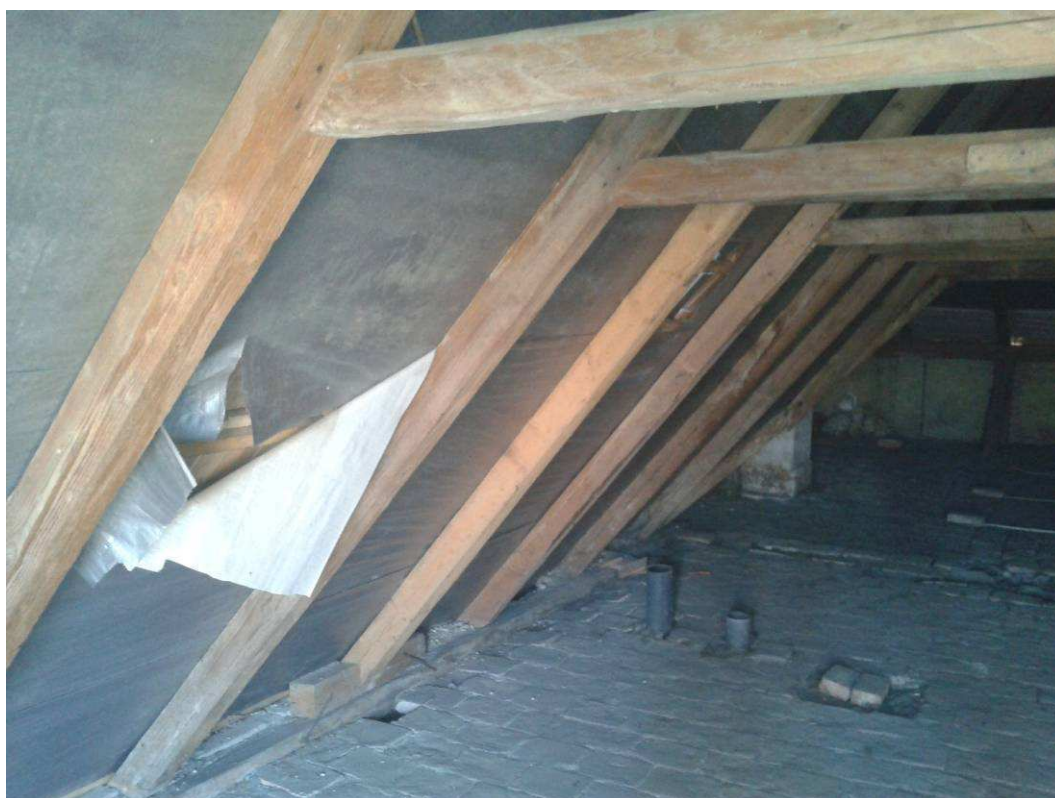
Udvari szélső fal talpszelemen, illetve szaruállások a torokgerendákkal
