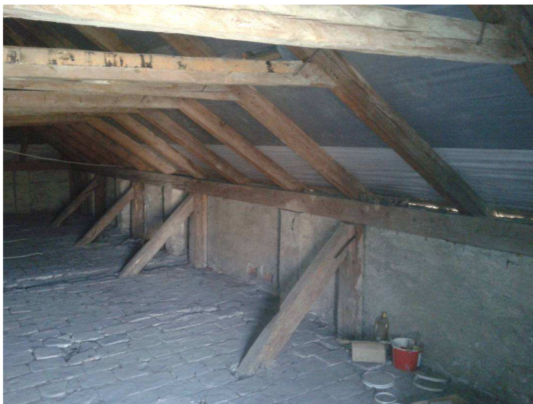
Külső oldali térdfal, illetve szaruállások a torokgerendákkal
