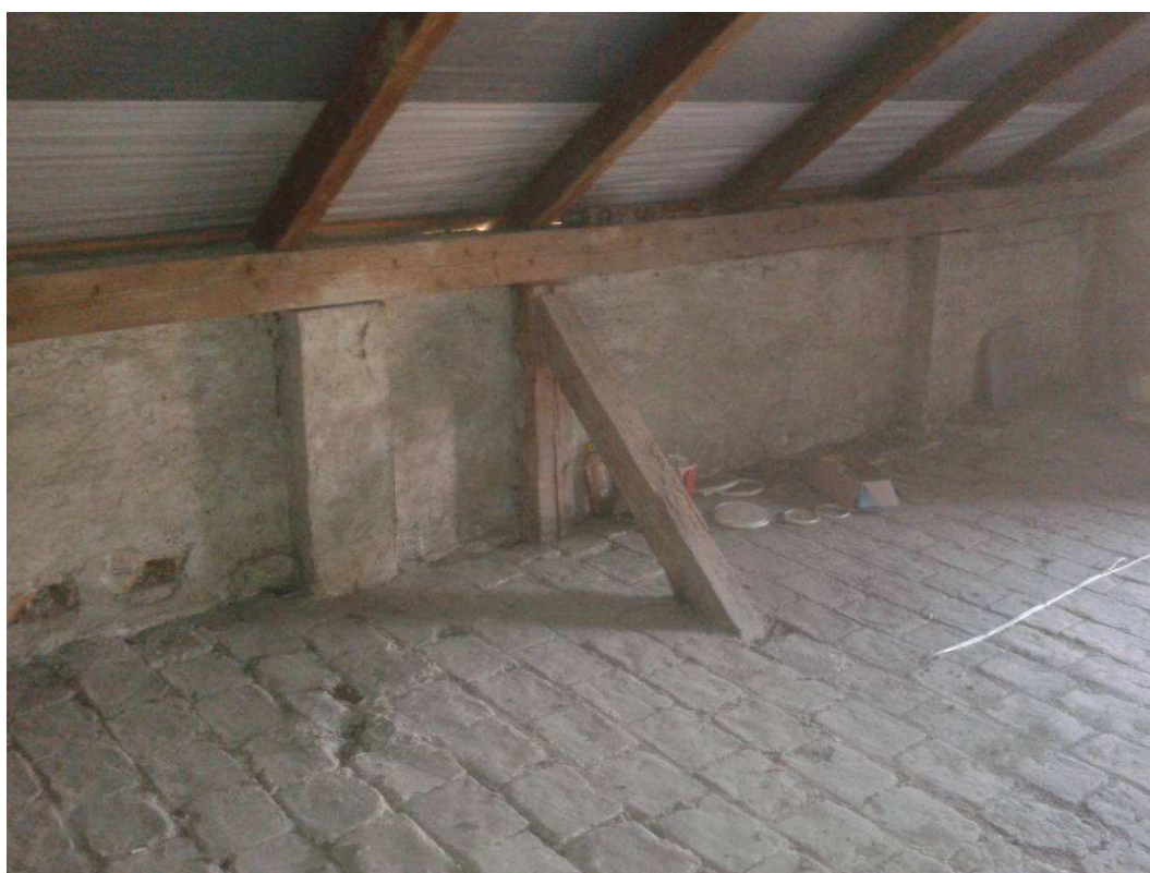
Külső oldali homlokzat térfala a ferde visszakötő dúccokkal.
