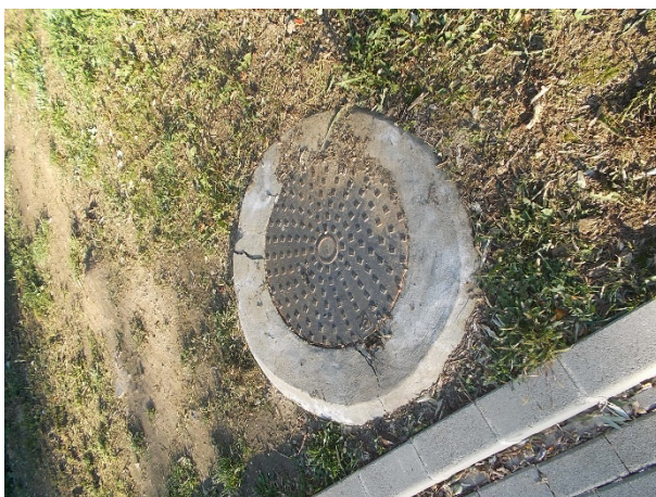
Aknafedlap beton gallérja nem megfelelő
