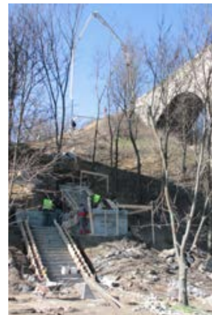
A viadukthoz vezető lépcső munkálatai
