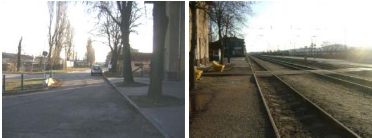
4.1-16. ábra Budaörs állomás jelenlegi állapota
