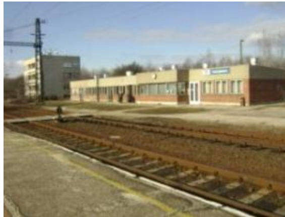
1.6-6. ábra Herceghalom vasútállomás
