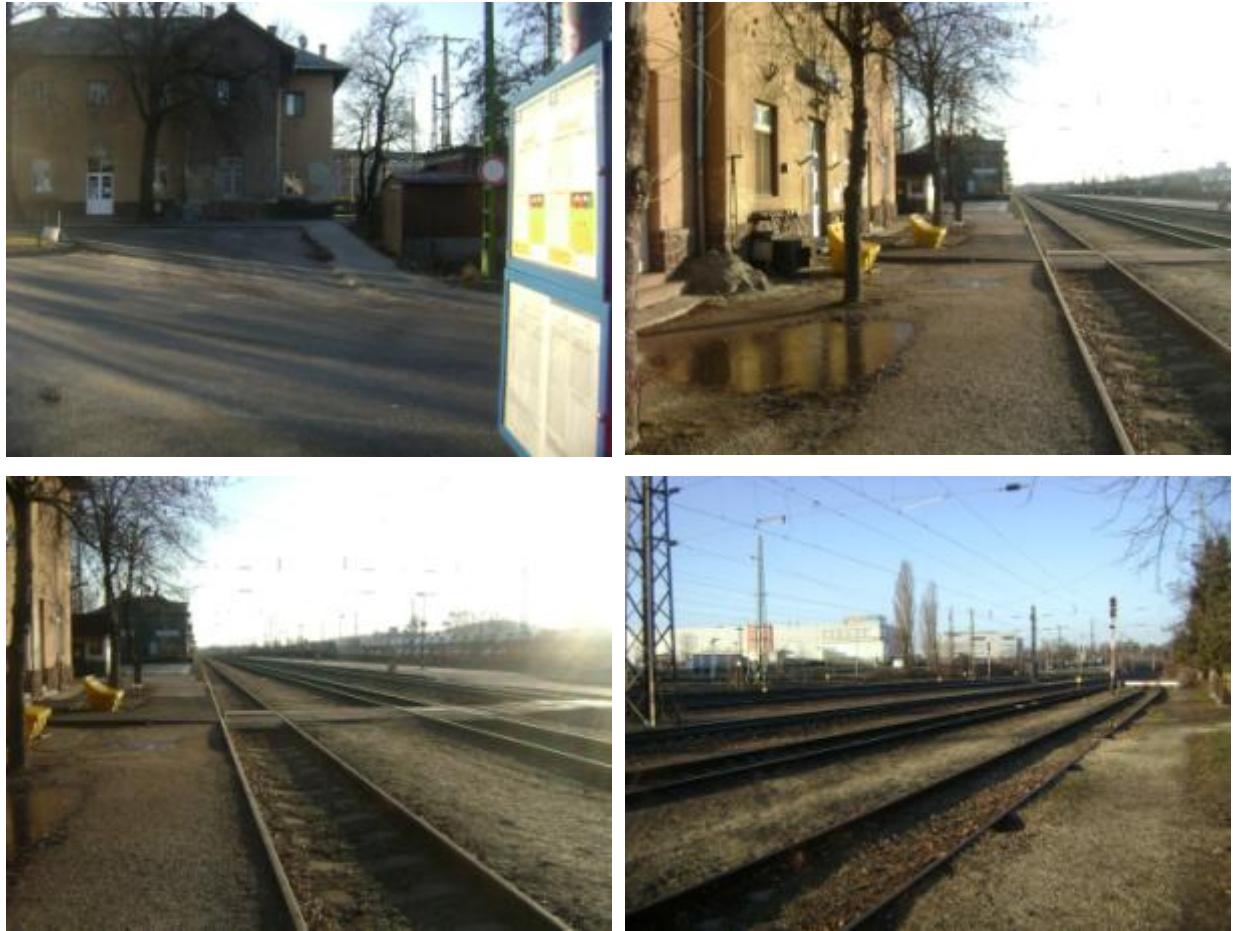
4.1-2. ábra Budaörs vasútállomás jelenlegi állapot
