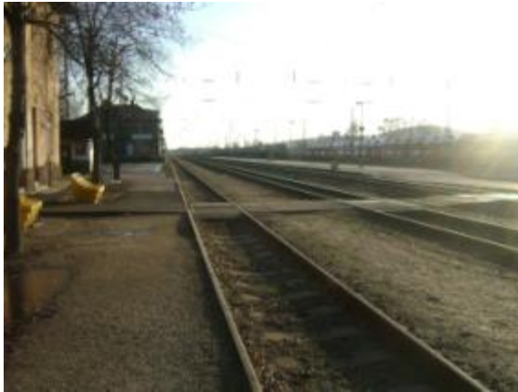
1.6-2. ábra Budaörs vasútállomás
