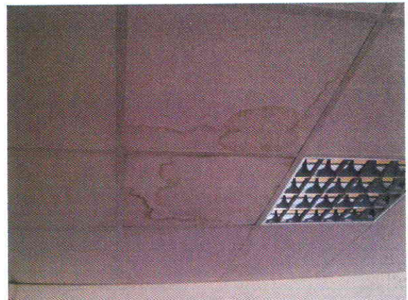
Beázási nyomok (több helyen)
