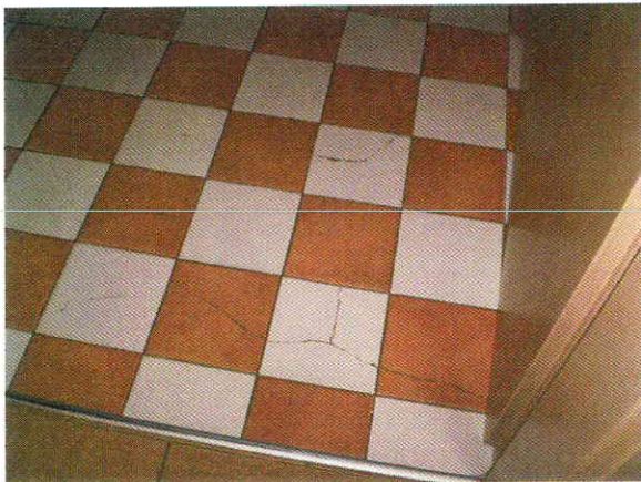
Padozatrepedések (több helyen)
