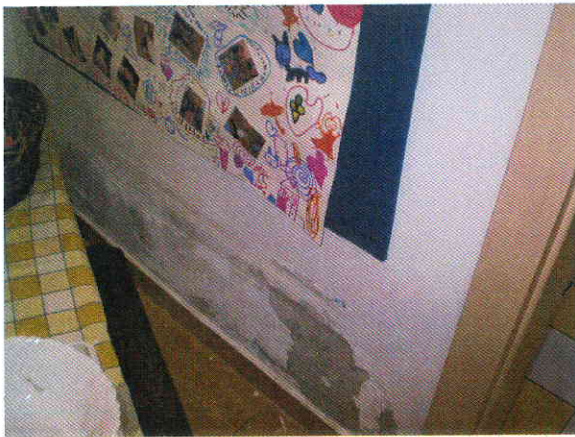
Felázási nyomok (több helyen).
