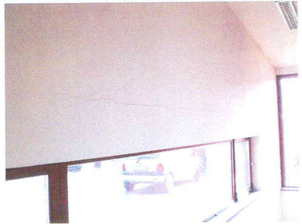
Függőleges és vízszintes repedések (több helyen)
