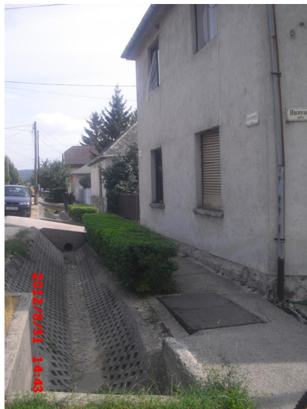
nyitott, betonozott csapadékgyűjtő csatorna – Széchenyi – Hunyadi utca sarkánál
