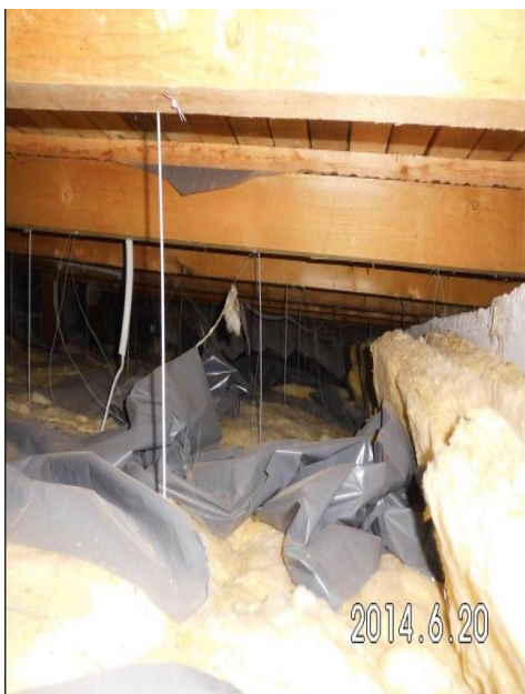
A beázás következtében az esővíz a tűzjelző érzékelőjéből, a lámpatestekből folyik.
