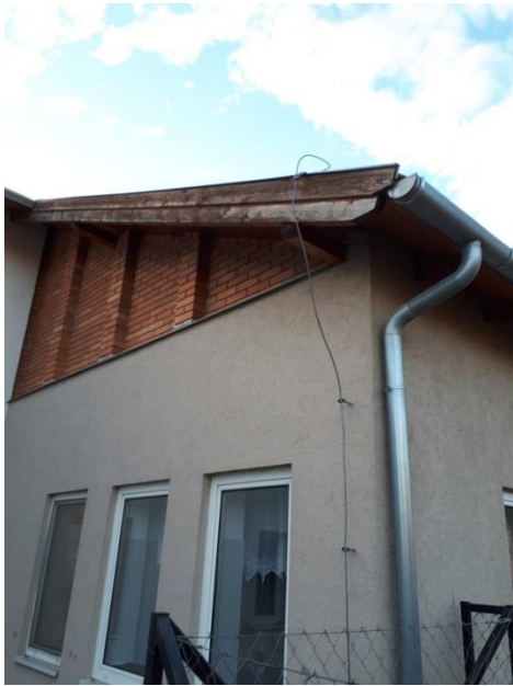
A régi épület faszerkezeteinek felülete kiszáradt.
