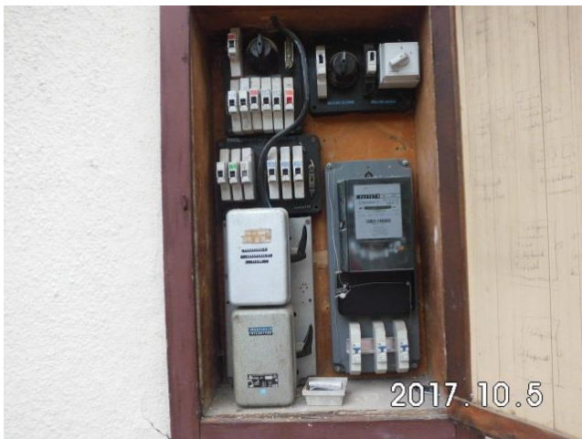
Nem csak a világítótestek, de az elosztószekrény és a régi alumínium vezetékek és kötéseik sem felelnek meg az előírásoknak
