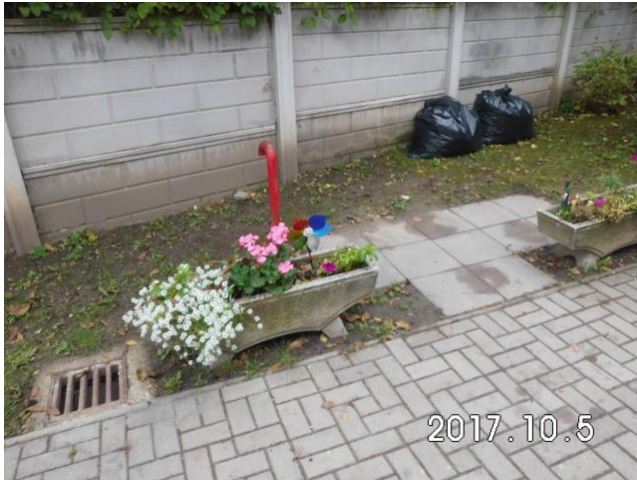
A piros cső a régi fűtőolaj-tartály szellőző csöve
