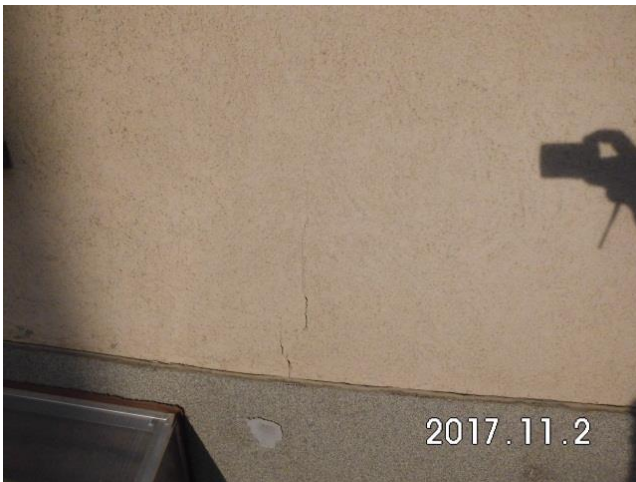
A lépcsőházi falon a dryvit burkolat megrepedt
