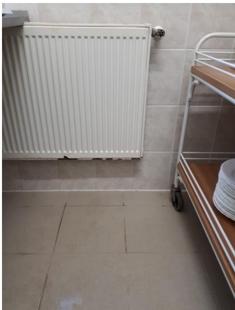
A vizes helyiségekben a radiátorok rozsdásodnak.
