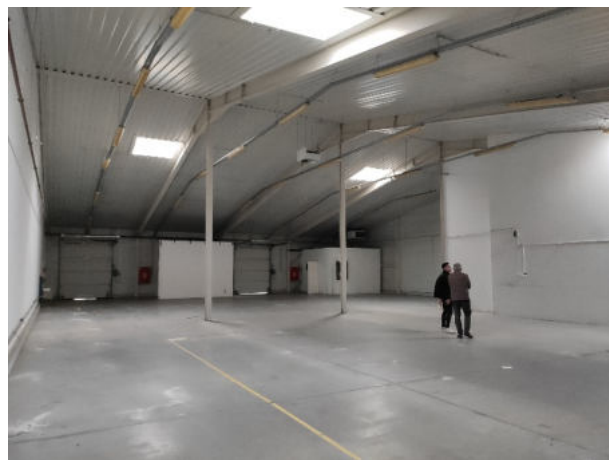
Meglévő raktárépület belső
