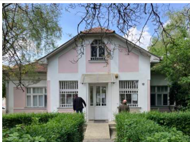
Az eredeti épület Vasút utca felőli bejárata
