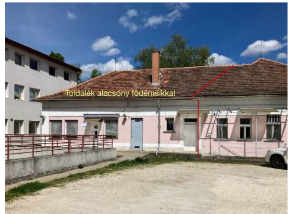
A védőnői épület toldaléka
