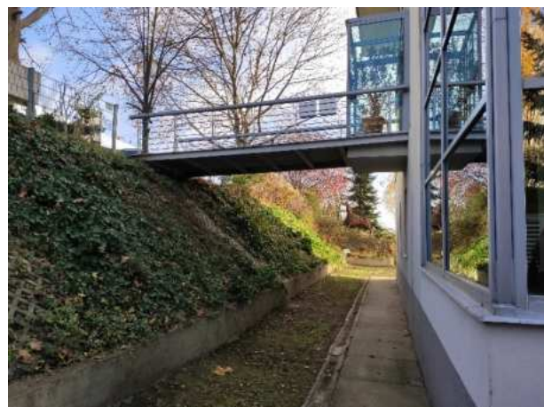
Előkert a Tormásrét utca felől rézsúvél és híddal
