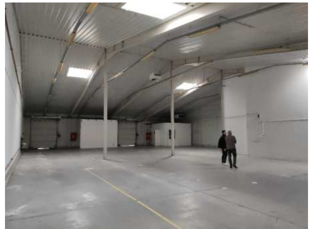
Meglévő raktárépület belső
