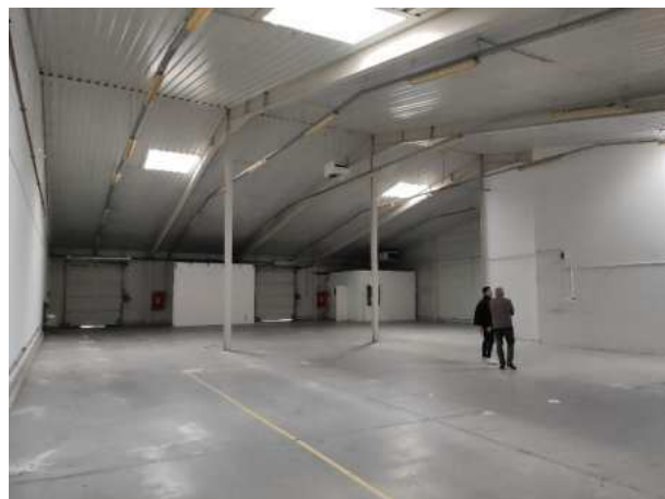
Meglévő raktárépület belső
