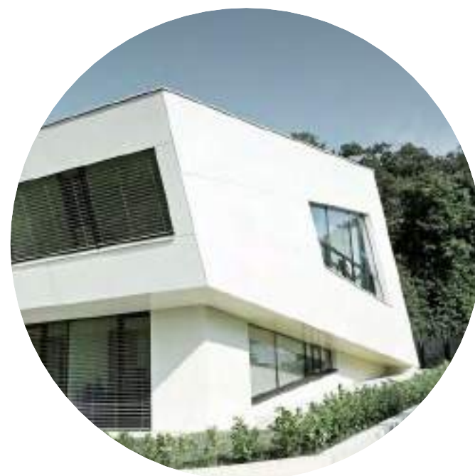
7) Szerelt alumínium kompozitlemez burk. (A2 maggal) - pl.: Prefa, Prefabond (~ RAL 9010 tisztafehér)
