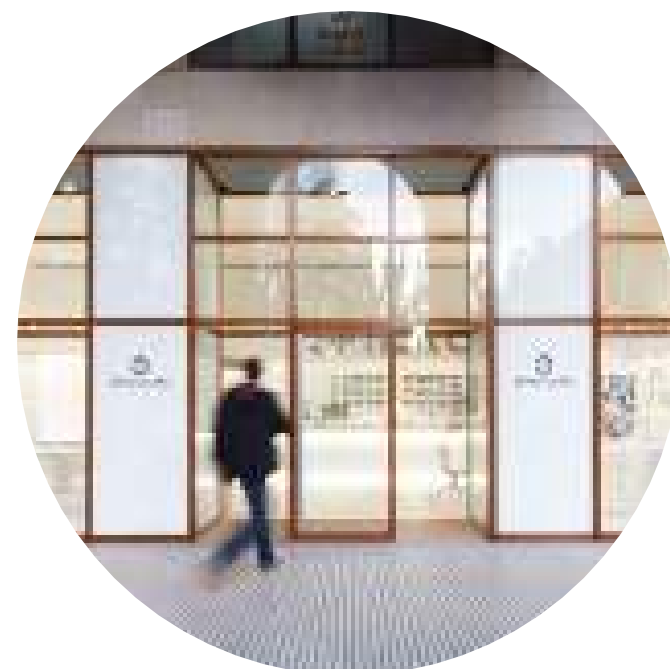
6), 9) - Fügönyfal kirakat pl.: Schüco - 3 rétegű üvegezés / fehér üve g shadow box (~ RAL9010 tisztafehér)
