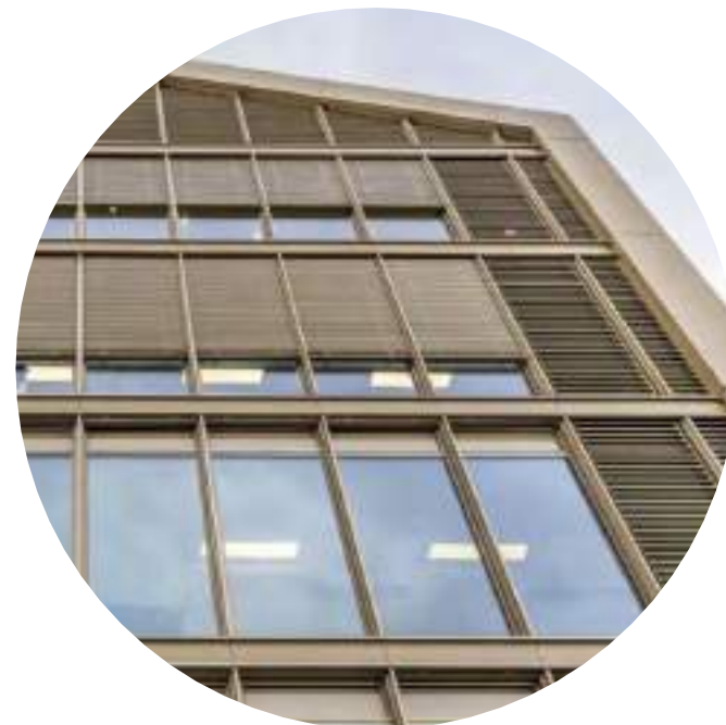
3) - Fügönyfal külső megjelenés pl.: Schüco - 3 rétegű üvegezés / zsaluzia elemekkel
