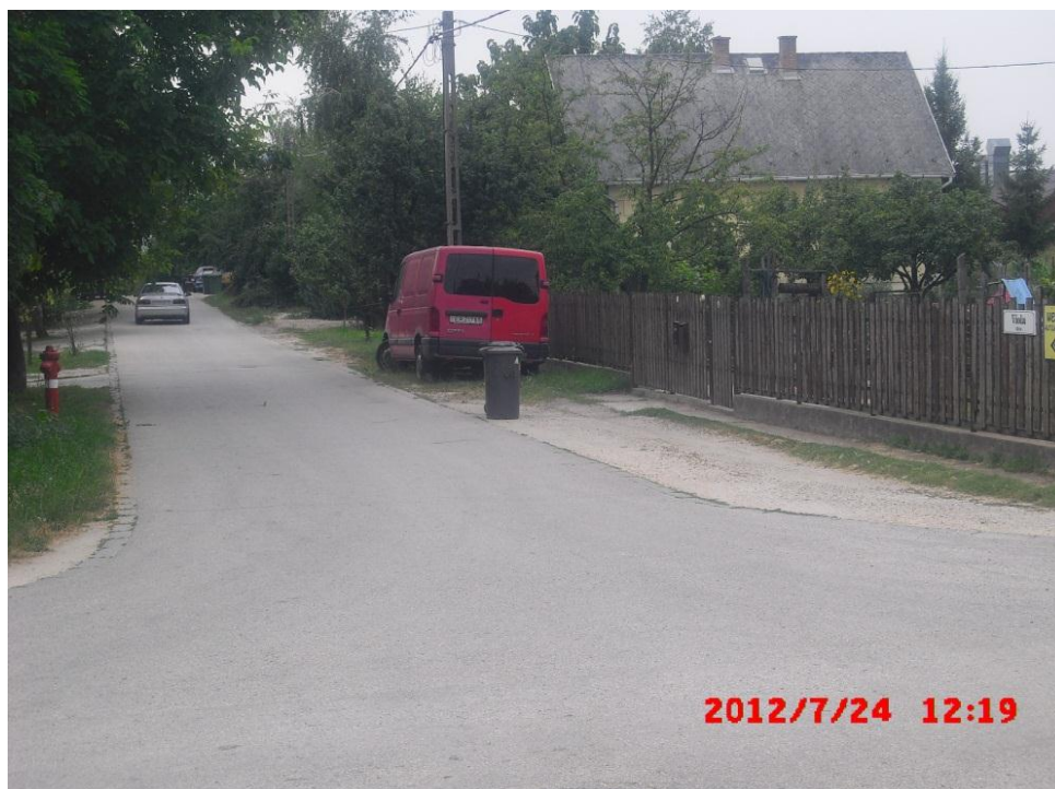
nincs csapadékelvezető árok – Viola utca
