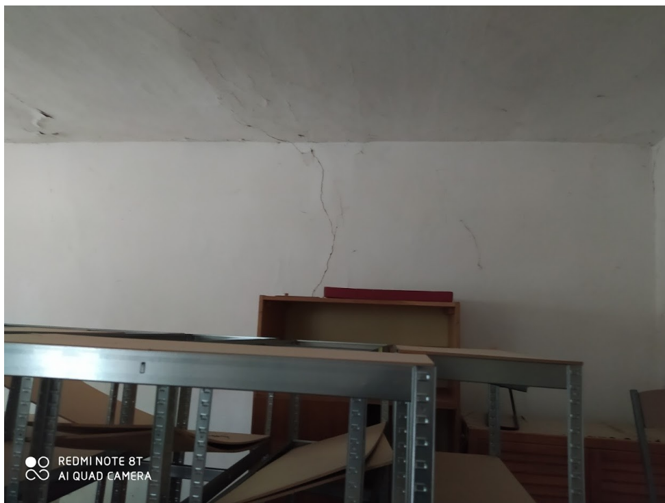
Repedt fal, repedezett mennyezet
