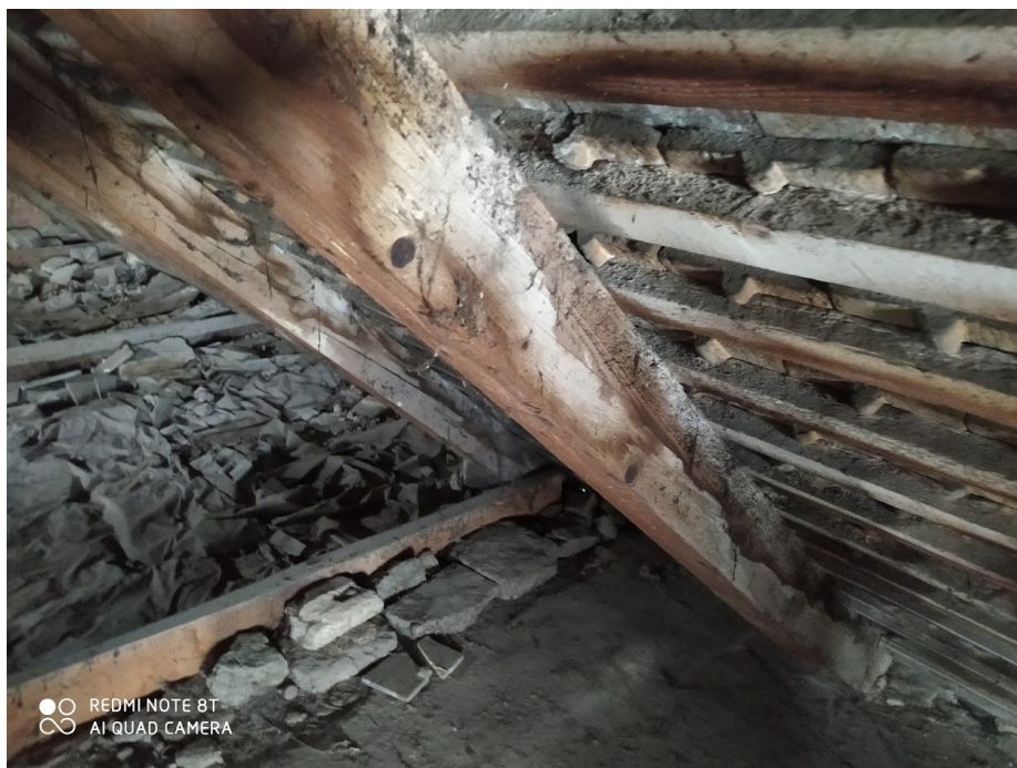
Intenzív beázási nyomok a szarufán, ami jelentős korróziót okozhat a földém fagerendáin.
