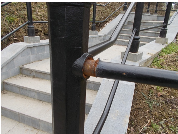
A korlát ragasztása nem megfelelő
