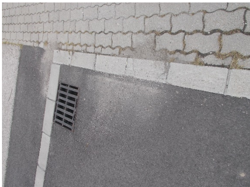
Aszfaltburkolat lejtése nem megfelelő
