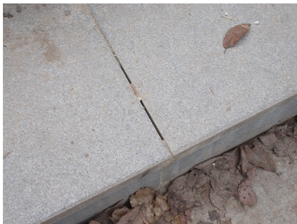
Fedkő ragasztása nem megfelelő
