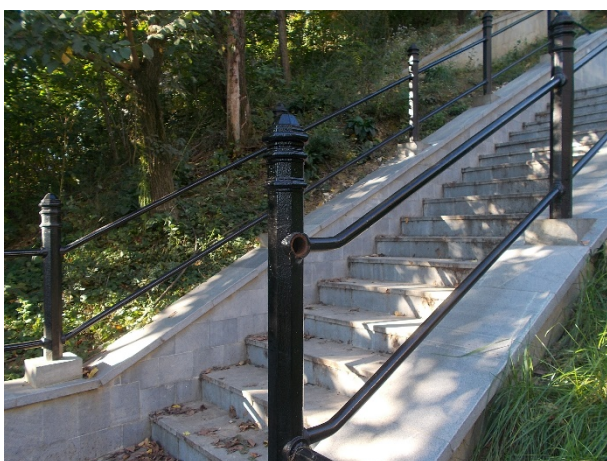
A korlát hegesztése nem megfelelő, korlátelem hiányzik
