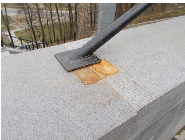
A korlát ragasztása nem megfelelő
