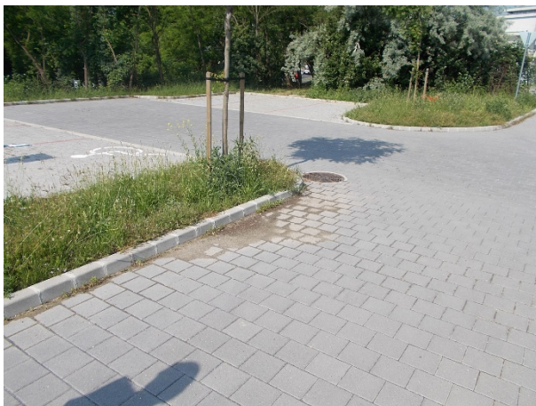
Aknafedlap beton gallérja nem megfelelő
