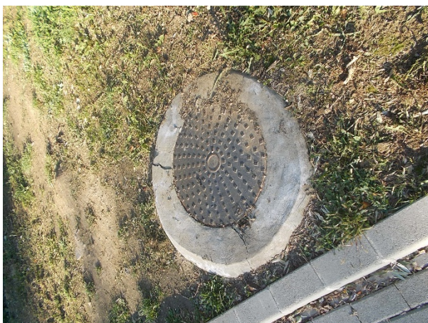
Aknafedlap beton gallérja nem megfelelő
