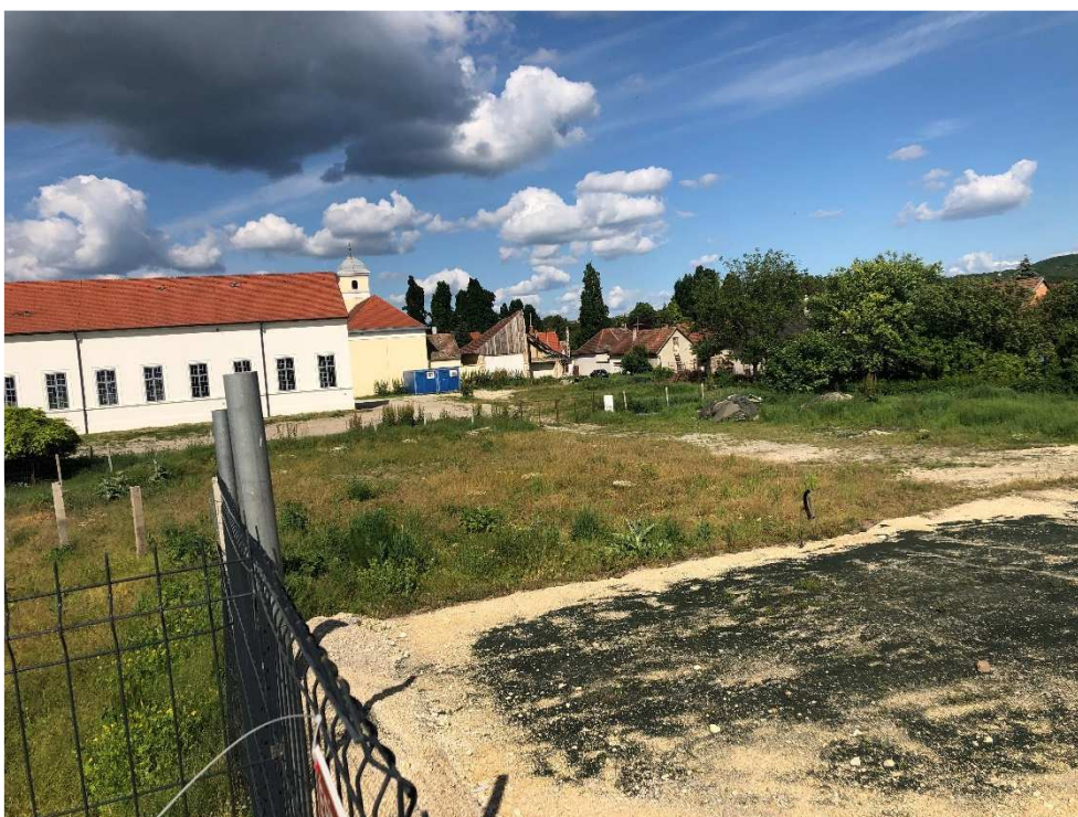
6. ábra: Az építési helyszín
