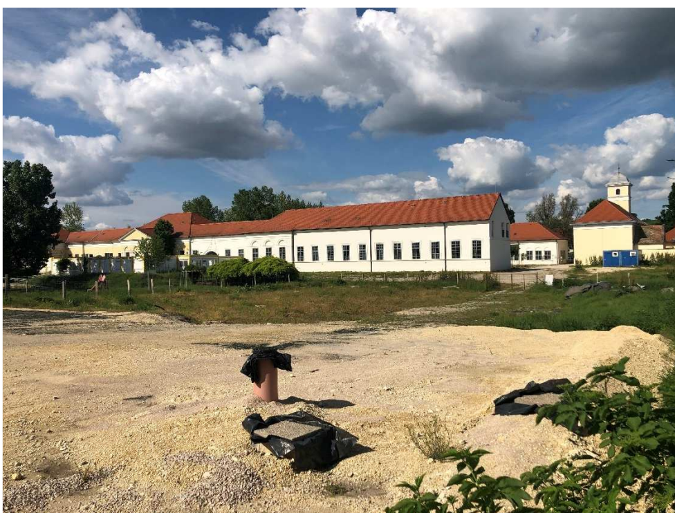
8. ábra: Az építési helyszín
